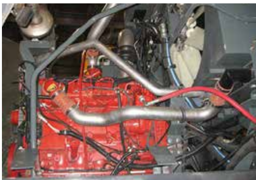
Motor diesel de Nivelul 3 - Vedere tipică
