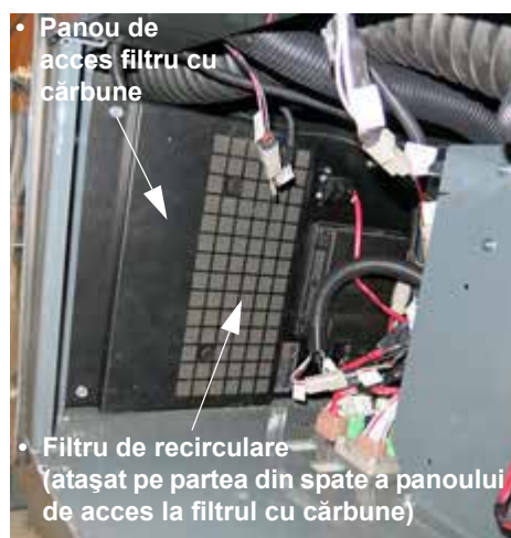
Panou de acces filtru cu cărbune (amplasat în spatele panoului de revizie exterior, pe partea dreaptă a cabinei) - Vedere tipică
