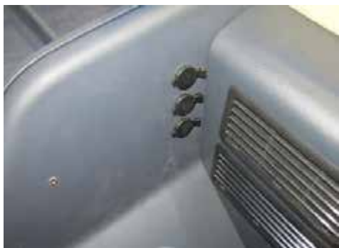
12V-os elektromos csatlakozók – A képen a tipikus felszerelés látható
