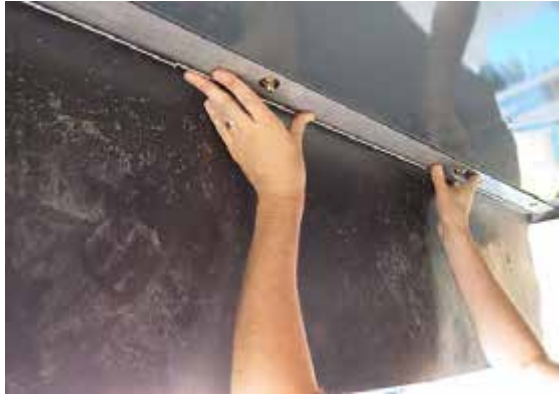
Súrolásvédelmi gumifüggöny telepítés – Tipikus nézet
