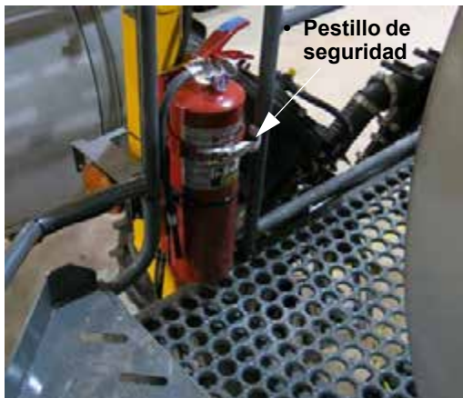
Extintor de incendios (ubicado junto a la pasarela en el lado izquierdo de la máquina) -Vista típica
