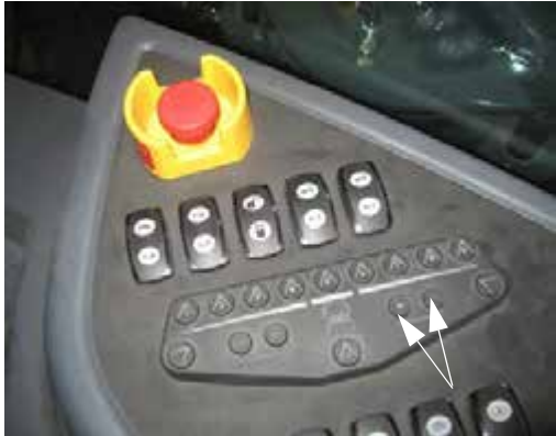
Interruptores de velocidad/flujo (ubicados en la consola lateral) -Vista lateral
