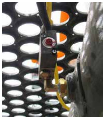
Elővezérlő szelep (elhelyezve a légtartály közelében) – Tipikus nézet
