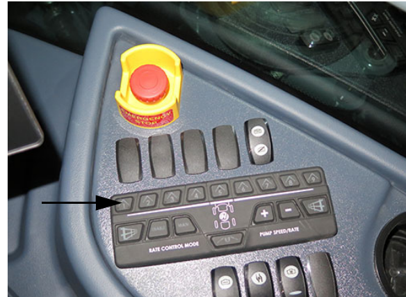
Gém permetlé szelep kapcsolók - Különálló permetlé mód, 1-9 szakaszok (oldalkonzolon) – Tipikus nézet
