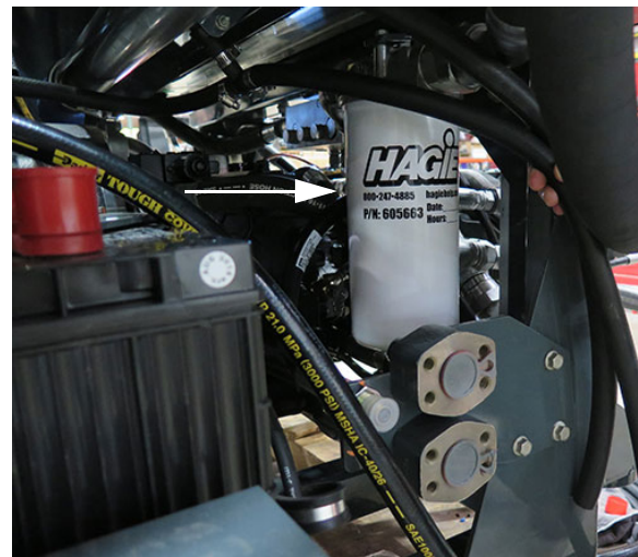
1. ház leeresztő szűrő (a munkagép jobb oldalán, az akkumulátorok közelében található) – Tipikus nézet
