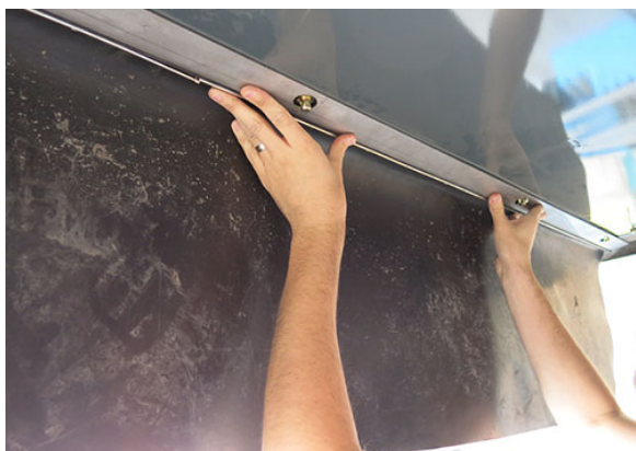
Súrolásvédelmi gumifüggöny telepítés – Tipikus nézet
