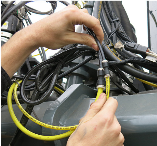
Conexiune marcator cu spumă (în față, pe partea dreaptă a utilajului) - Vedere tipică
