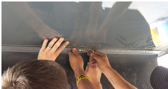
Știft de fixare (instalat în știftul barei de suspendare) - Vedere tipică
