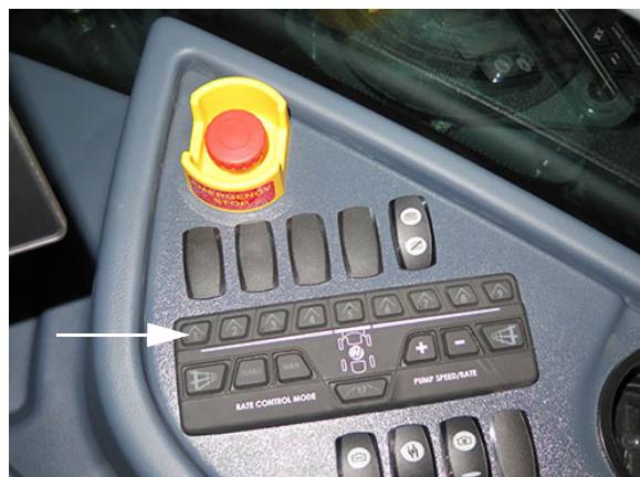
Comutatoare supape de soluție de pe brațe (pe consola laterală) - Vedere tipică
