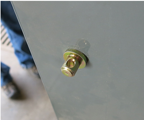
Instalare știft bară de suspendare - Vedere tipică
