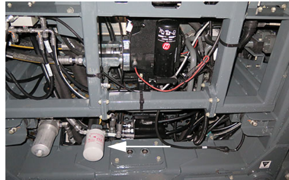
Vypúšťací filter skrine 2 (Nachádza sa na ľavej strane stroja pred rámom motora) - Typický pohľad
