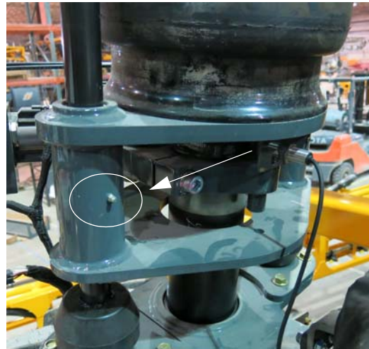
塔轴承润滑脂加油嘴 (位于前后立腿上) - 典型视图
