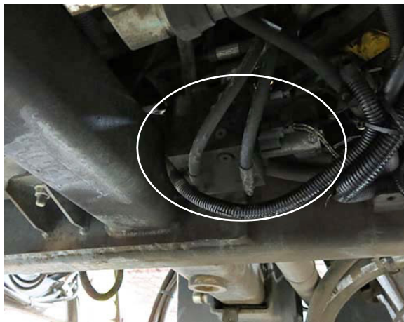
Colector de válvulas (ubicado en la parte inferior de la máquina) -Vista típica
