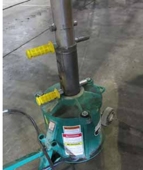
Installation des goupilles de blocage - Vue typique
