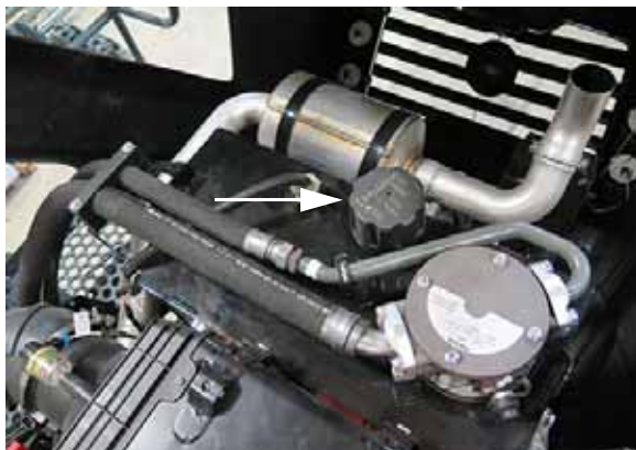
Bouchon de reniflard (situé sur le dessus du réservoir d'huile hydraulique) - Vue typique
