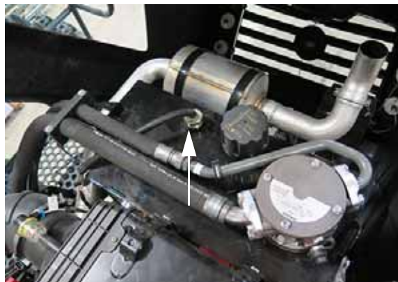
Capteur de niveau/température (situé sur le dessus du réservoir d'huile hydraulique) - Vue typique
