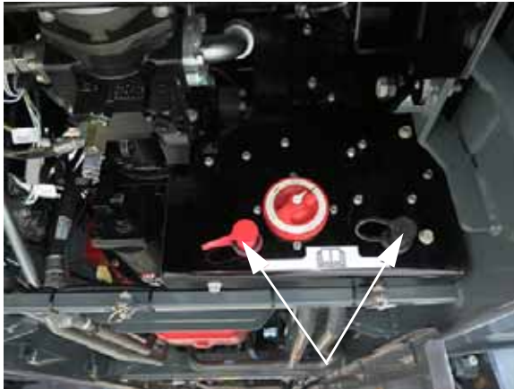
Bornes de charge de la batterie auxiliaire (situé sur le châssis principal arrière) - Vue typique
