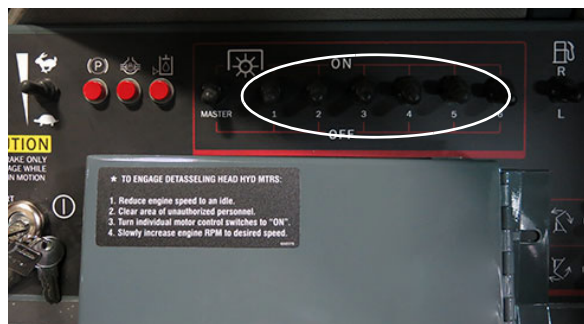
Interruptores de control de los motores de los cabezales de la despenachadora (ubicados en la consola lateral) -Vista típica
