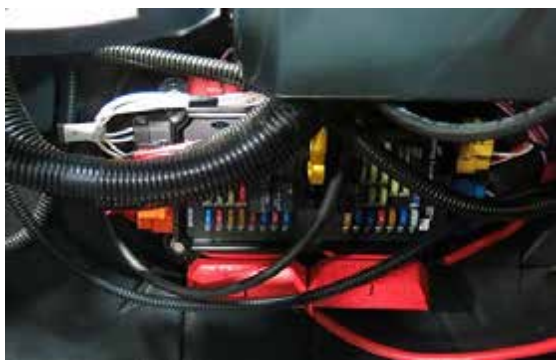
Caja de fusibles/relés (con la tapa quitada) - Vista típica
