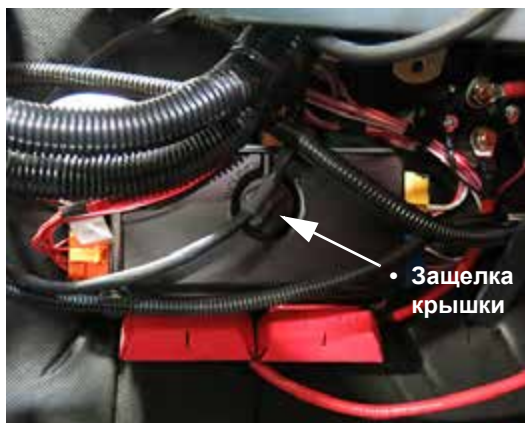
Коробка с предохранителями/реле (находится возле пола под боковой панелью) – стандартный вид
