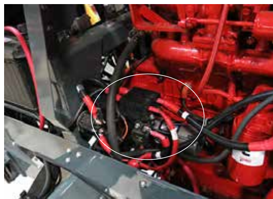
Устройство отключения жгута проводов и Предохранители (находятся справа двигателя) – стандартный вид
