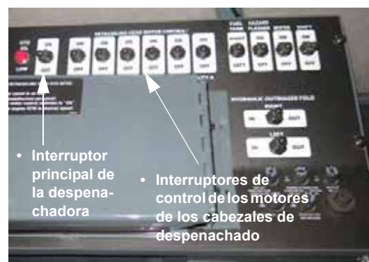
Interruptor principal de la despenachadora e interruptores de control de los motores de los cabezales de despenchado (ubicados en la consola lateral) -Vista típica
