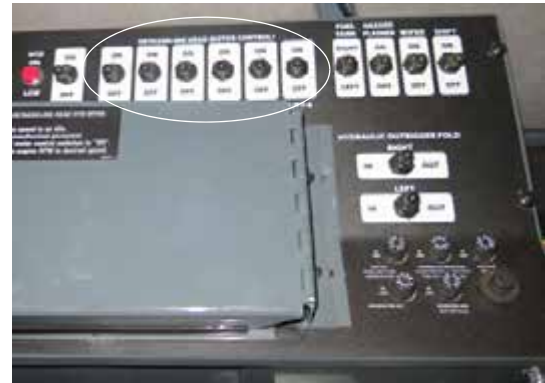
Interruptores de control de los motores de los cabezales de la despenachadora (ubicados en la consola lateral) -Vista típica
