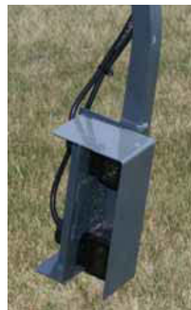
Senzor de lumină foto - Vedere tipică
