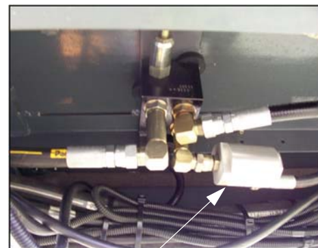
90 mikronos beépített szűrő (Az ábrán leszerelt rácsfedéllel látható) -Jellemző nézet
